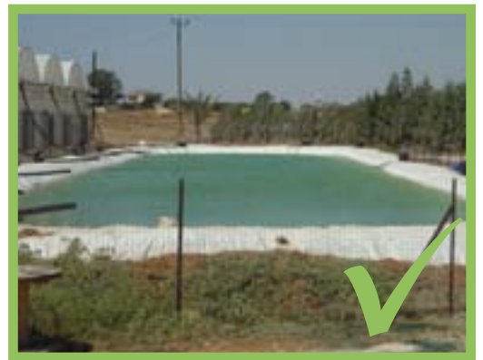
Zäunen Sie Wasserspeicher, Gräben oder Gräben ein oder verhindern anderweitig den Zugang.
