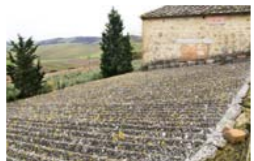
Dächer in gutem Zustand können belassen werden.
