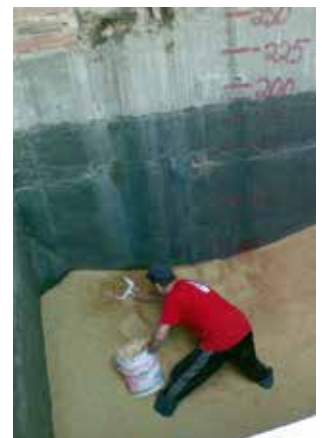
Asigurați ventilarea corespunzătoare a silozurilor după fumigație și înainte de a autoriza accesul în acestea.
