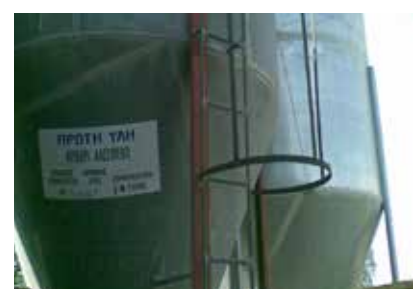
Vstup do stísněných prostor.
