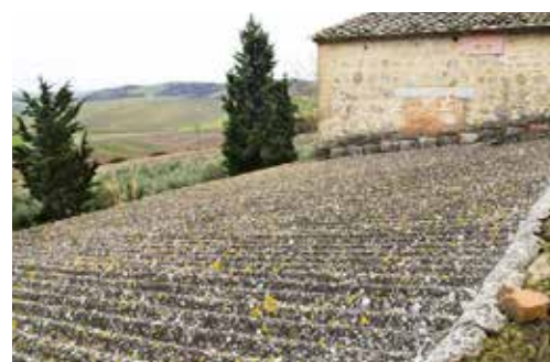
Dachy, których stan ocenia się na dobry, mogą pozostać na miejscu
